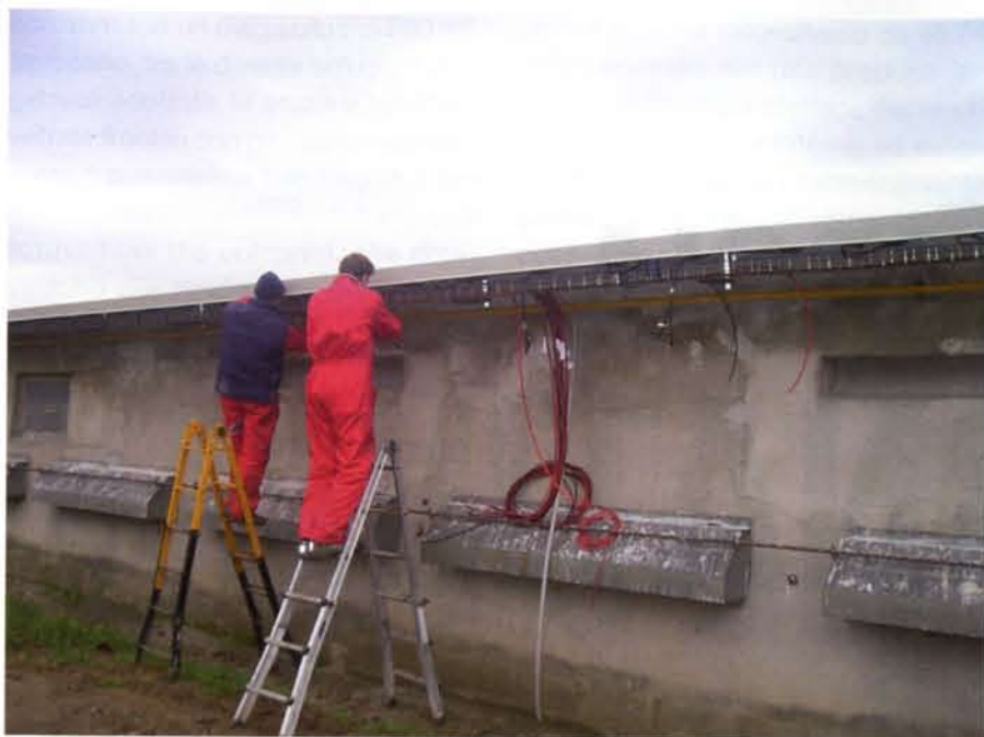
UN MOMENTO DELLA FASE DI MONTAGGIO DELLA PARTE ELETTRICA DELL'IMPIANTO DI VICENZA (AZIENDA AGRICOLA SCALCHI CARLO)
