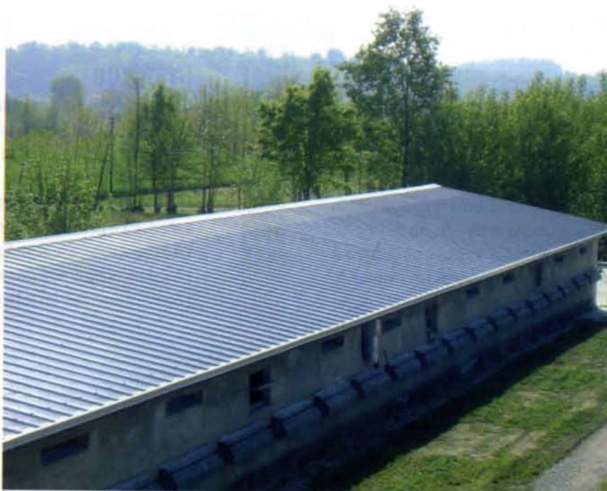
L'AZIENDA AGRICOLA SCALCHI CARLO DI MONTÉGALDA (VI) SI OCCUPA DI ALLEVAMENTO DI POLLI. LA DISCONTINUITÀ DEL TIPO DI PRODUZIONE CONSENTE DI CEDERE IN RETE CIRCA IL 20% DELL'ENERGIA PRODOTTA ATTRAVERSO I PANNELLI COIBENTATI FOTOVOLTAICI A FILM SOTTILE
